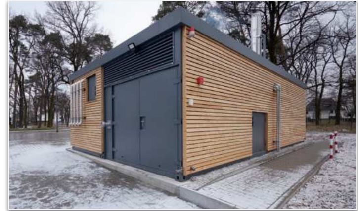
Beispiel Energiezentrale: Biomasse Containerlösung
